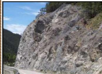
Les travaux de sécurisation des parois de la RD902 en venant de Briançon avaient débuté cet automne et été interrompu prématurément avec l'arrivée de mauvaises conditions météo. Ces travaux ont repris au printemps et ont duré presque un mois et demi avec l'installation d'une circulation alternée. Voilà la route bien protégée des chutes de pierres par l'installation de filets métalliques.
