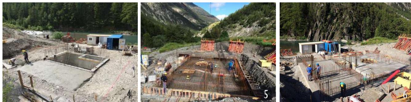
Élévation des murs de l'étage turbine (photo 7), et des murs périphériques (photo 8).
