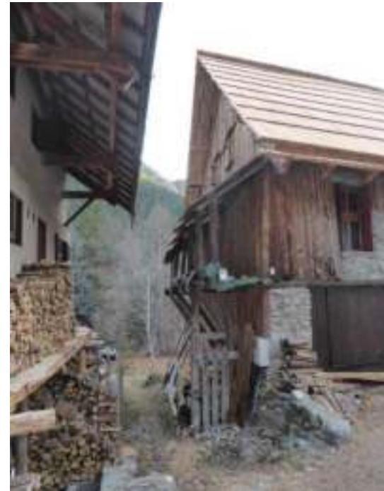
RÉHABILITATION EN COURS
