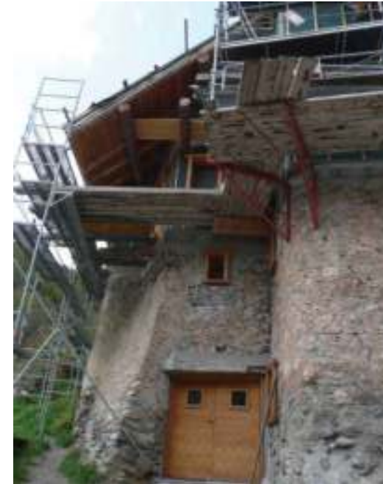
RÉHABILITATION EN COURS
