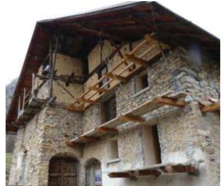
RÉHABILITATION CHALET EN COURS
