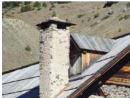
LUCARNE DE TYPE JACOBINE, EN BÂTIÈRE OU À CHEVALET ET SOUCHE DE CHEMINÉE MAÇONNÉE
