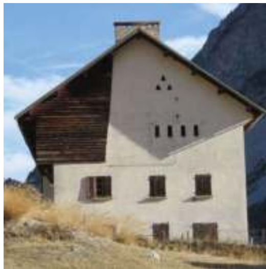
MIXITÉ DES PAREMENTS ET DIFFICULTÉ DE MISE EN OEUVRE
