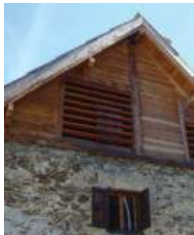
VOLET À VANTELLES INTÉGRÉ DANS BARDAGE BOIS HORIZONTAL POSITION OUVERTE ET FERMÉE
