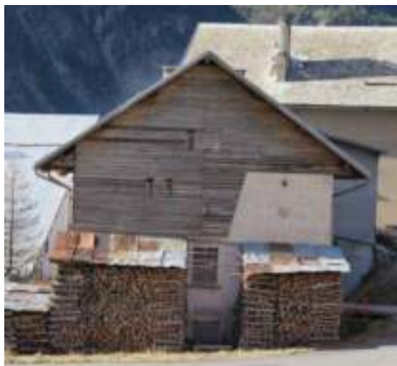
MURS MAÇONNÉS ET BARDAGE BOIS
