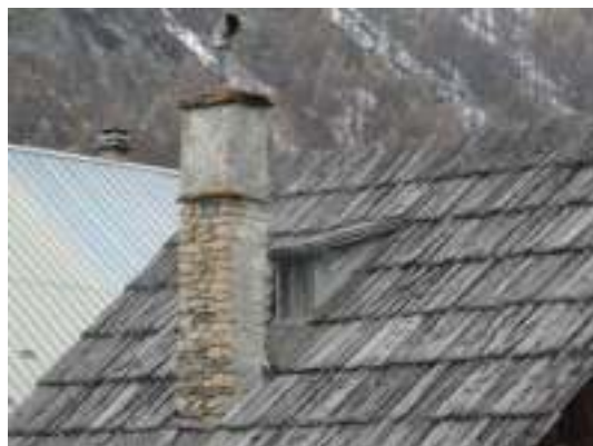
LUCARNE DE TYPE CHIEN ASSIS, RETROUSSÉE ET SOUCHE DE CHEMINÉE MAÇONNÉE
