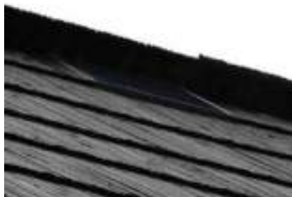
PANNEAU DANS TOITURE BARDEAU
