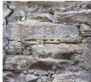
EXEMPLE DE MAÇONNERIE DE SOUBASSEMENT EN PIERRE. CHAÎNE D'ANGLE, ARC, REMPLISSAGE
