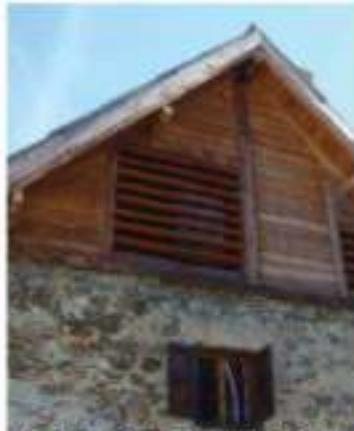
VOLET À VANTELLES INTÉGRÉ DANS BARDAGE BOIS HORIZONTAL POSITION OUVRETE ET FERMÉE.
