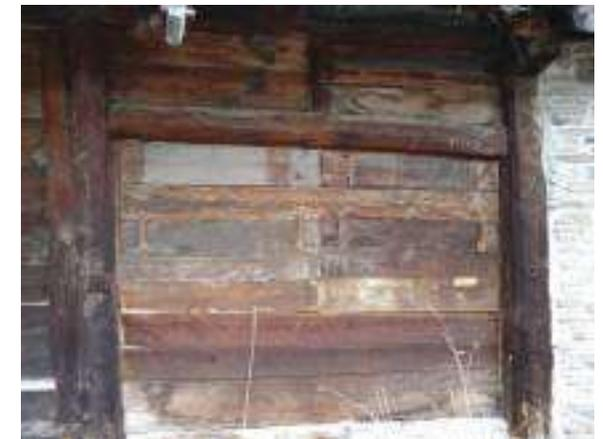
Configuration vantelles ouvertes bardage horizontal
