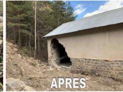
Il y a 1an, une chute de bloc d'environ 6m<sup>3</sup>, a endommagé la gare de départ du Téléphérique de Terre Rouge, occasionnant de gros dégâts. Une entreprise est intervenue dernièrement afin, d'évacuer les blocs et purger l'affleurement rocheux qui présentait encore une menace. Coût de cette opération : **26 060 € HT Subventionnée à 80%** (Etat, Département, DRAC)
